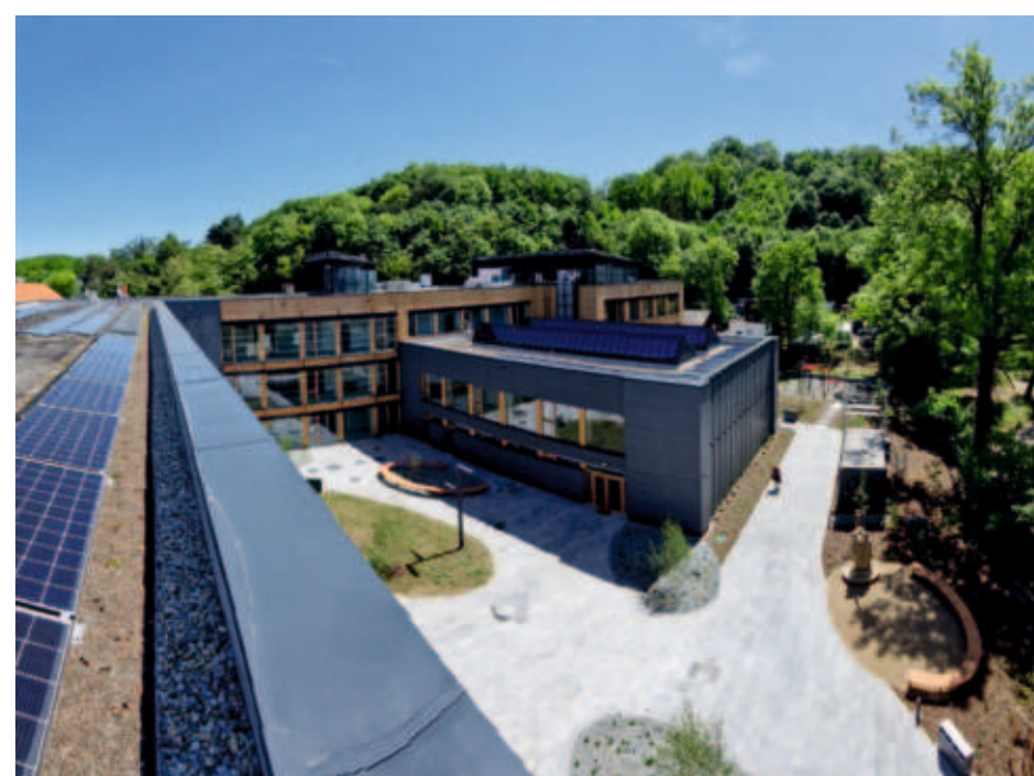
Práce s povrchy - členění ploch zelených a dlážděných (velkoformátová dlažba); biosolární střecha kombinující extenzivní vegetační souvrství a fotovoltaické panely.
